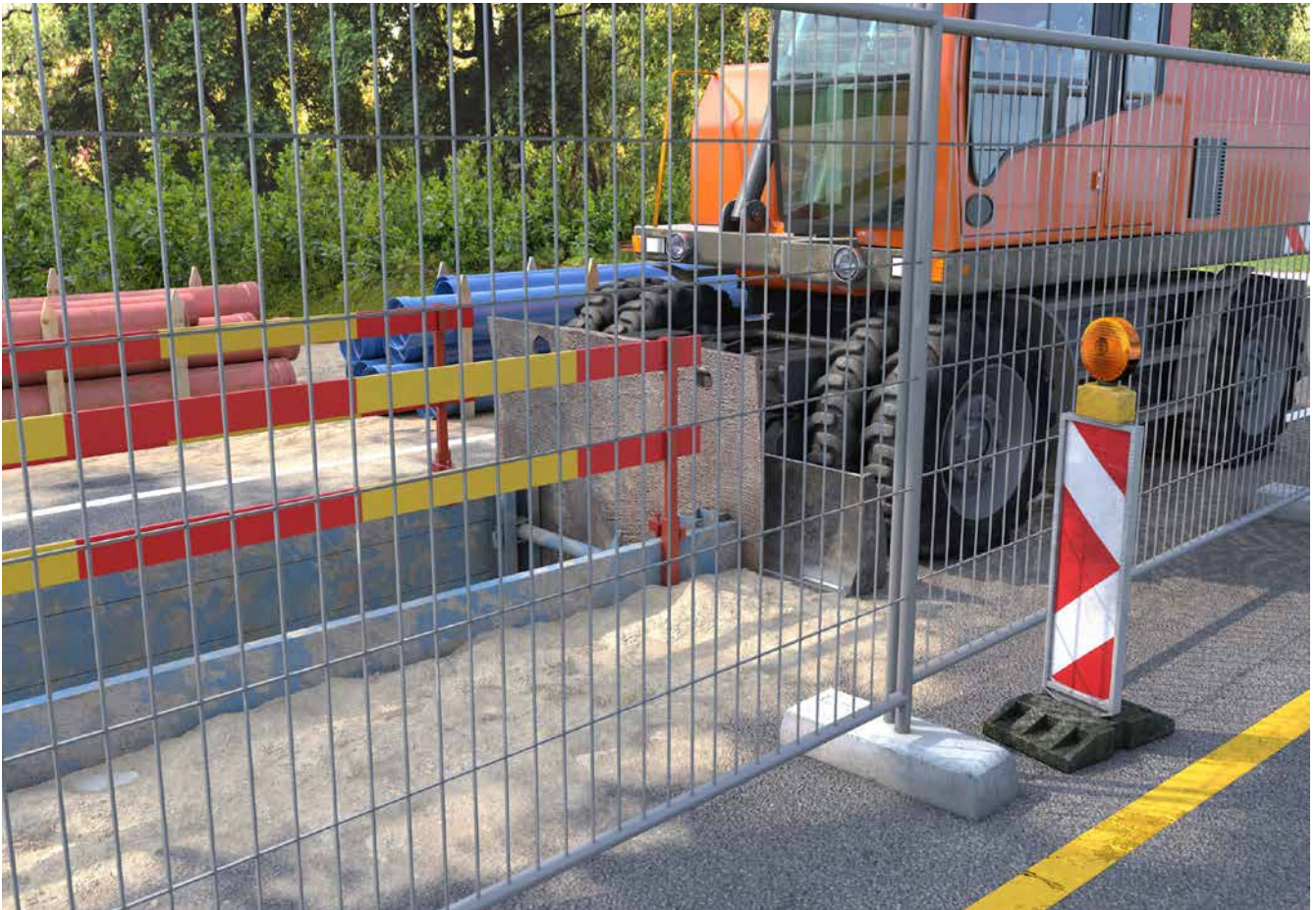
Abb. 109 Sicherung der Stirnseite des Verbaus
