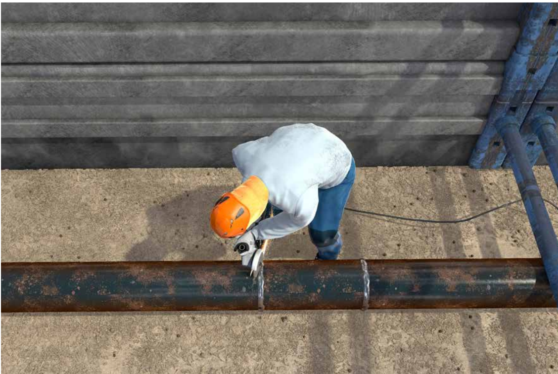
Abb. 120 erhöhte elektrische Gefährdung
