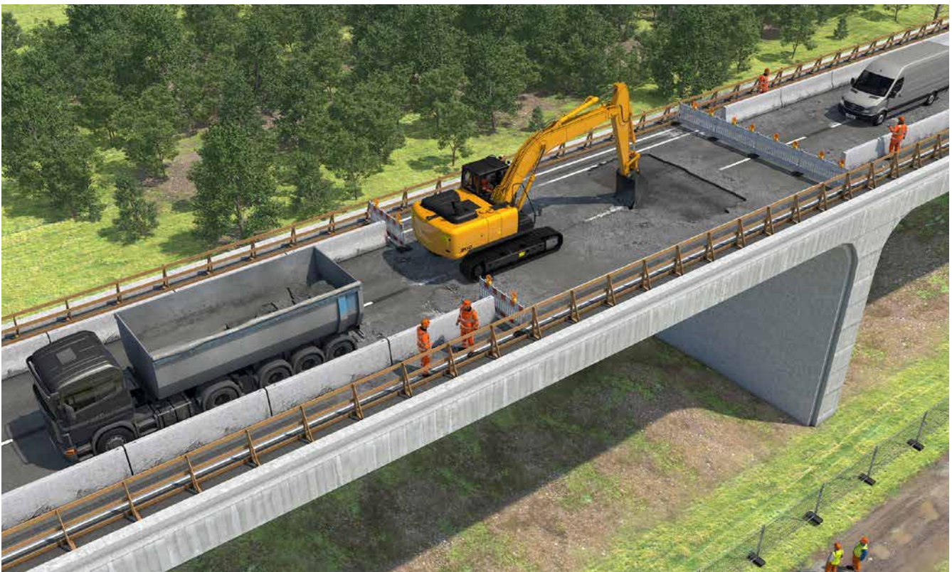
Abb. 77 Absturzsicherung für Fahrzeuge und Baumaschinen durch massive Begrenzung des Fahrweges
