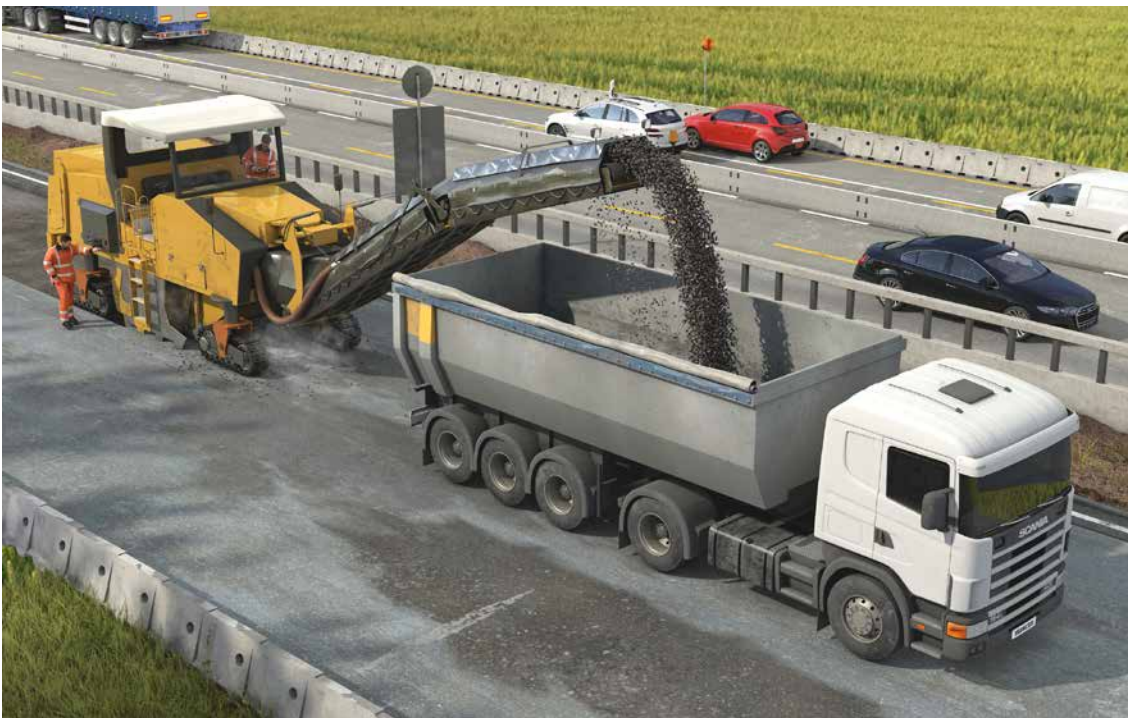
Abb. 7 Arbeiten im Schutze einer Vollspernung
