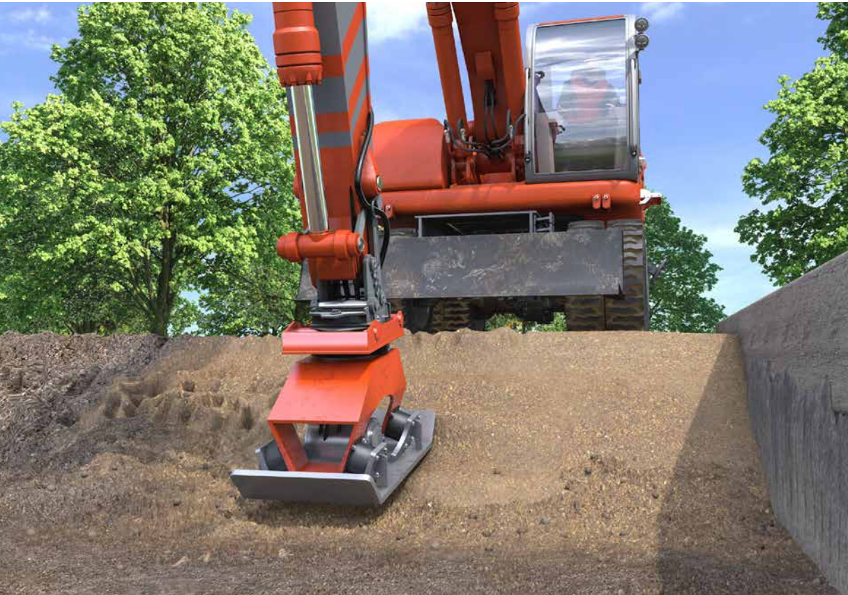
Abb. 45 Reduzierung von körperlichen Belastungen bei Verdichtungsarbeiten durch Einsatz von Anbauverdichtern
