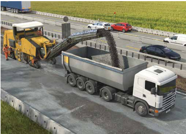
Abb. 102 Großfräse mit Absaugung
