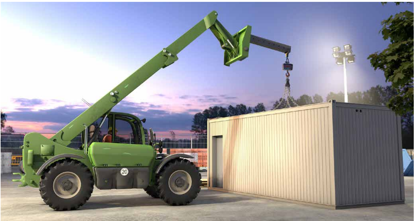
Abb. 61 Sichteinschränkung beim Versetzen großformatiger Lasten
