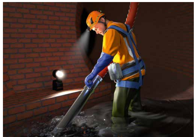
Abb. 15 Beispiel für Schutzkleidung und PSA bei Arbeiten in abwassertechnischen Anlagen
