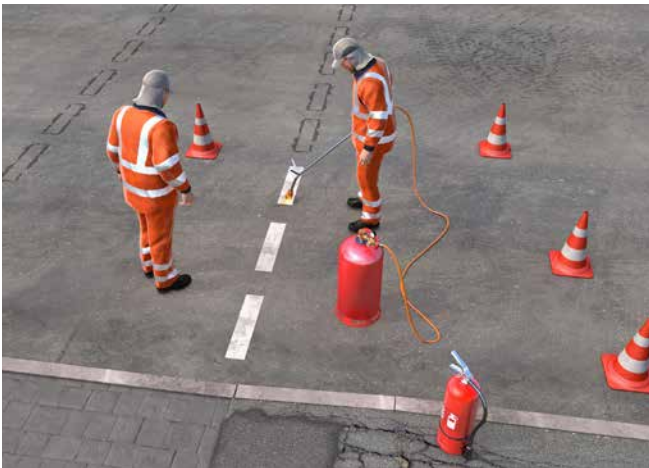
Abb. 103 Straßendemarkierungsarbeiten
