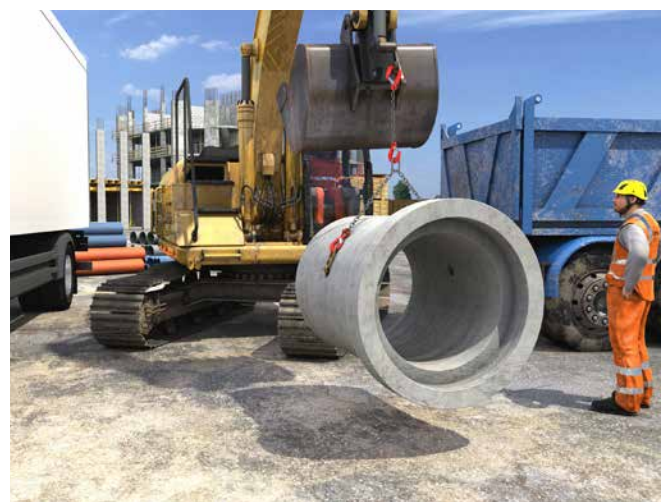
Abb. 88 Transport einer formschlüssig angeschlagenen Last
