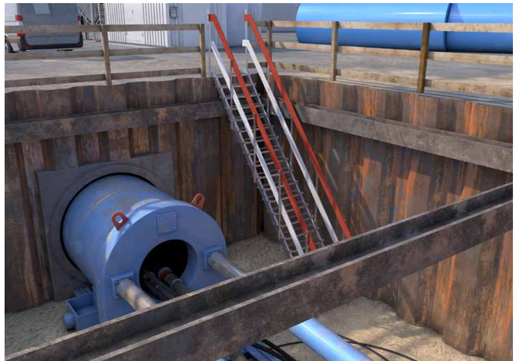
Abb. 135 Unbemannte Rohrvortriebsarbeiten, Baugrube mit Treppenzugang
