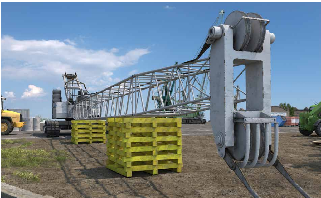
Abb. 131 Auf Pallungen abgelegter Ausleger eines Seilbaggers
