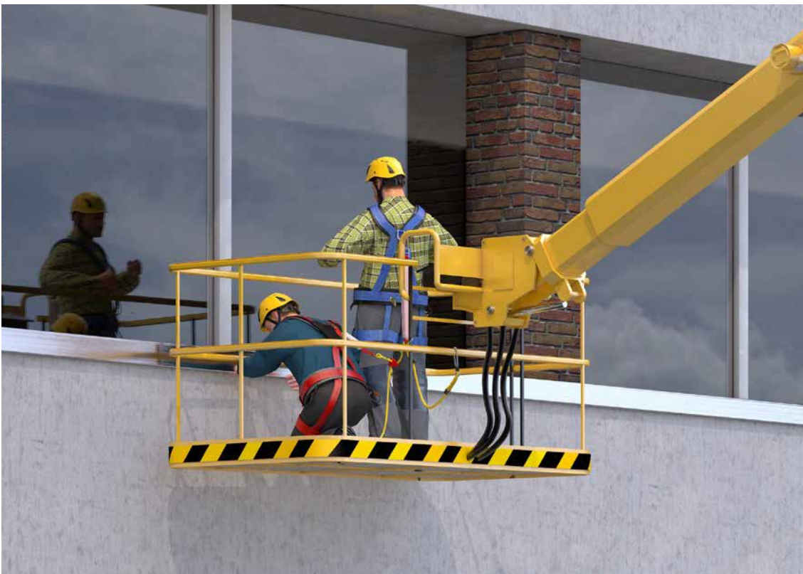
Abb. 62 Auffanggurt mit vorderer/hinterer Auffangöse und längenverstellbares (max. 1,80 m) Verbindungsmittel mit Falldämpfer
