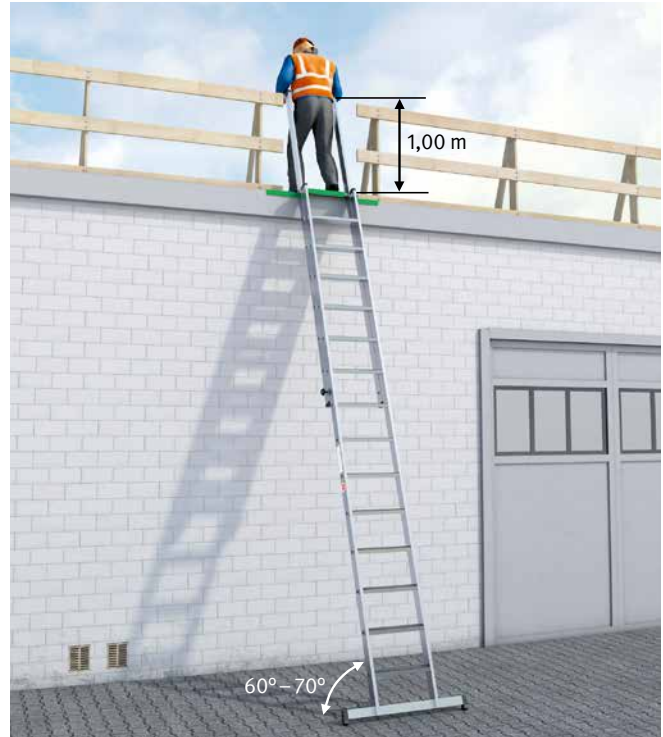
Abb. 6 Einsatz von Anlegeleitern als Verkehrsweg
