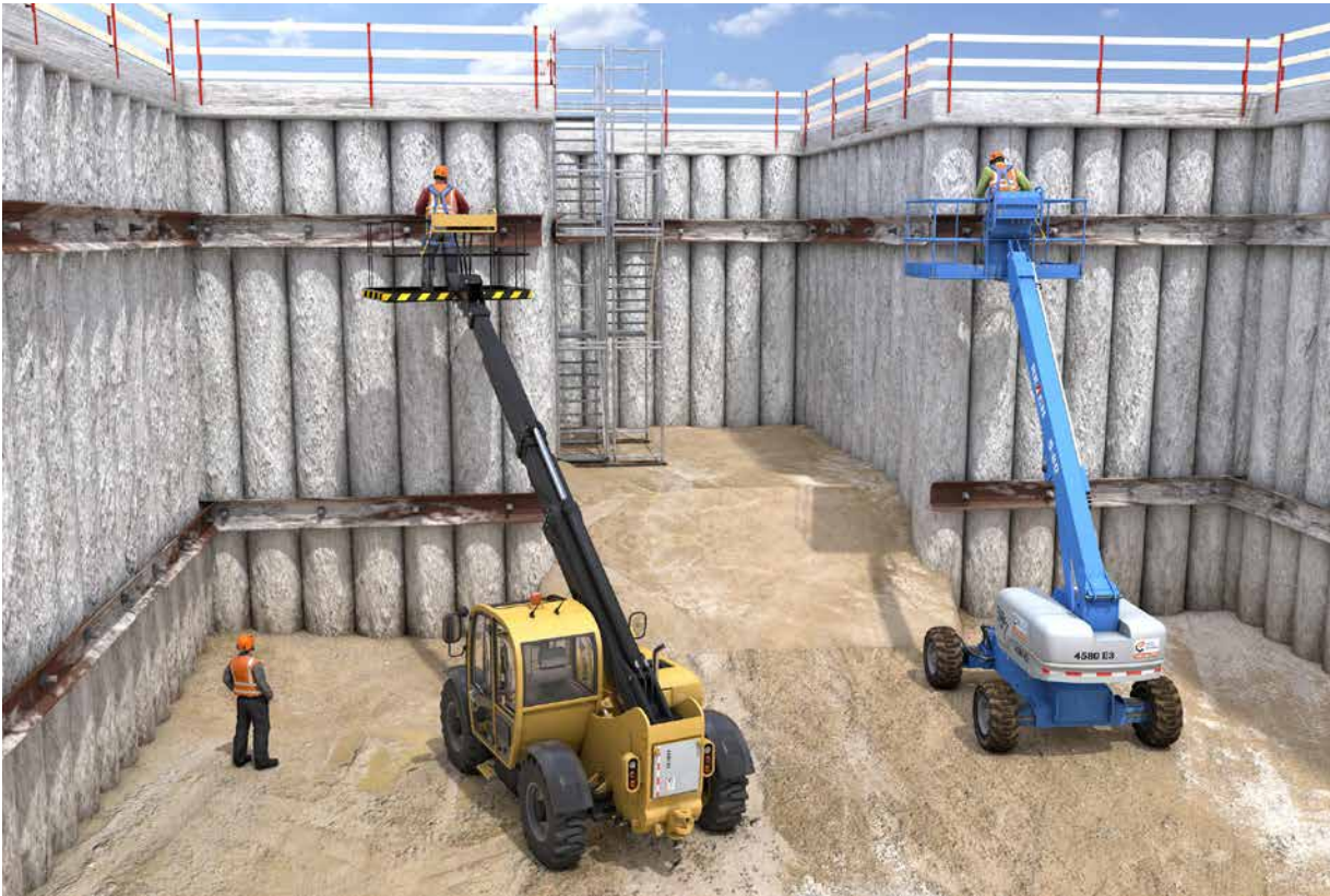
Abb. 89 Hubarbeitsbühne und Teleskopstapler für das Heben von Personen
