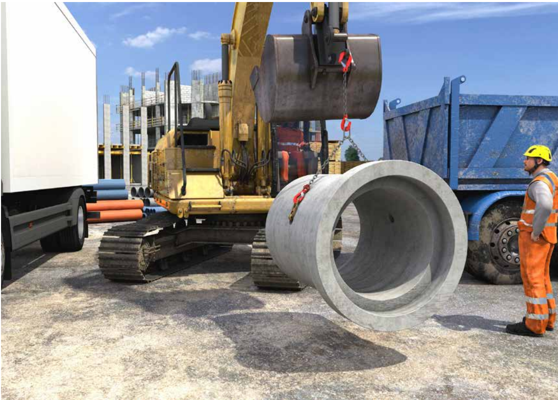
Abb. 58 Transport einer formschlüssig angeschlagenen Last
