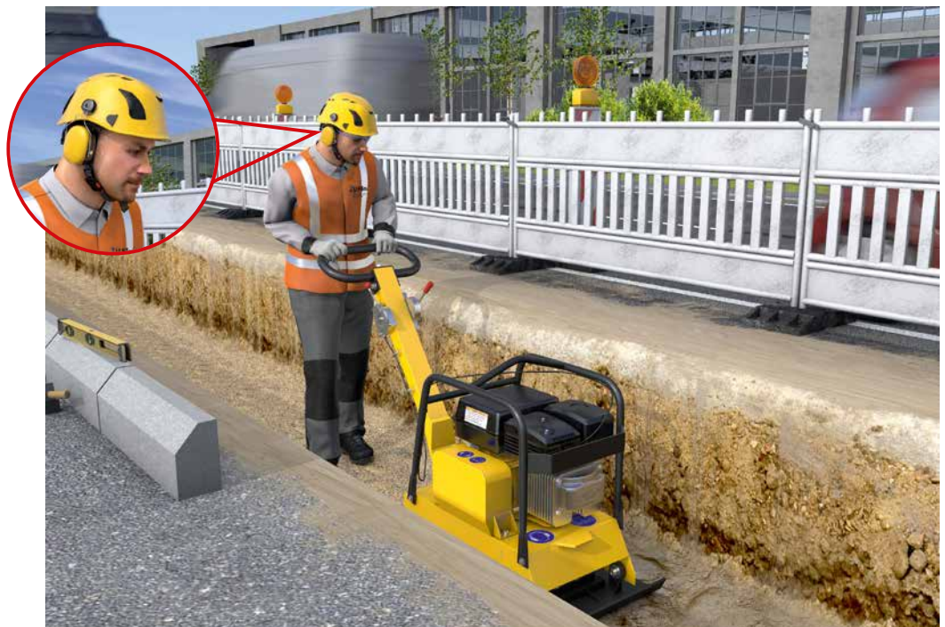
Abb. 54 Verdichtungsarbeiten mit geeignetem Gehörschutz
