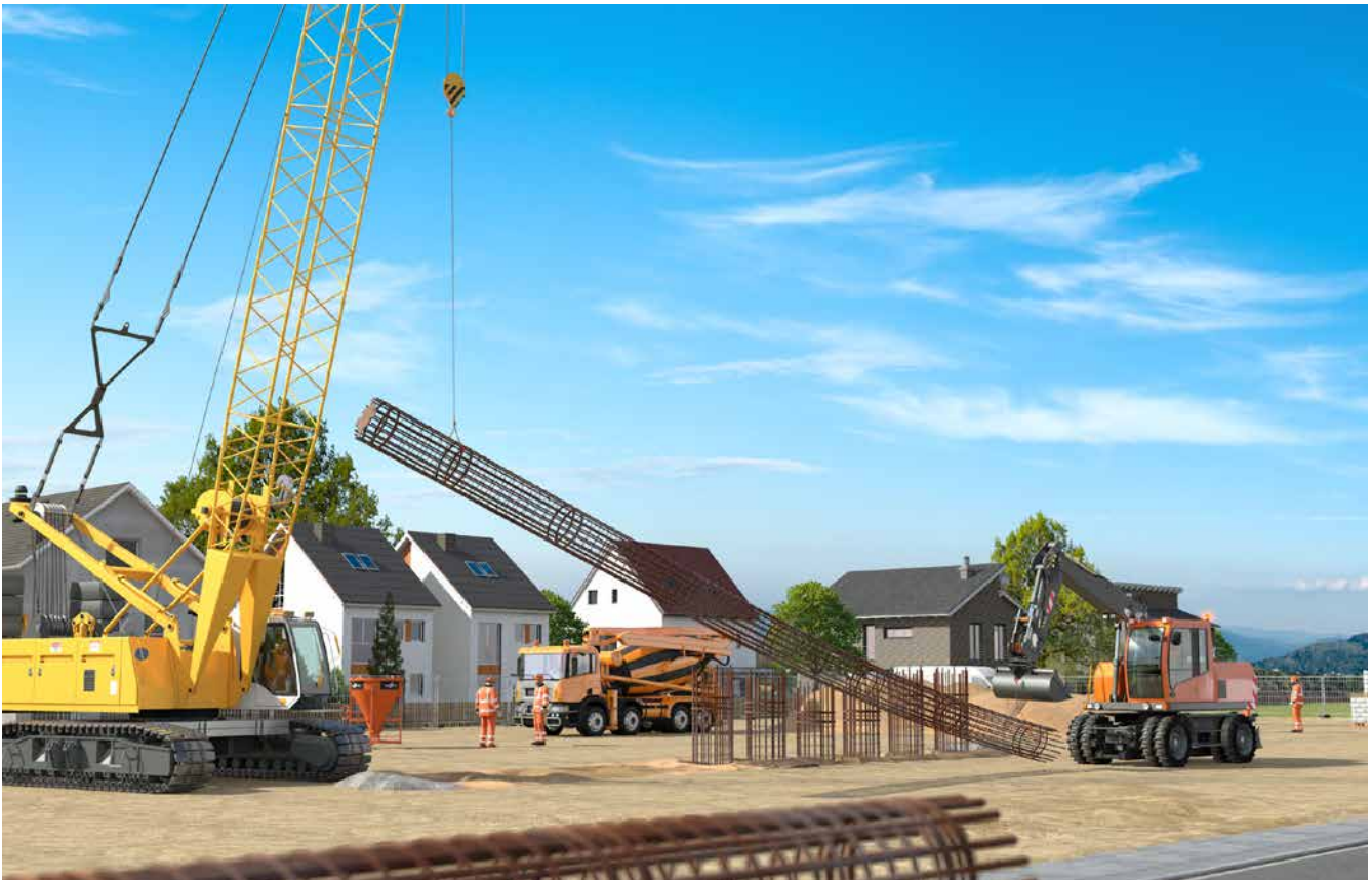
Abb. 126 Heben eines Bewehrungskorbes
