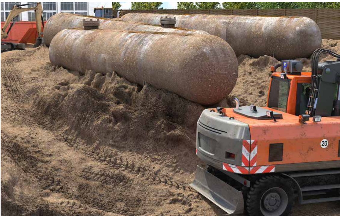
Abb. 16 Erdarbeiten in kontaminierten Bereichen
