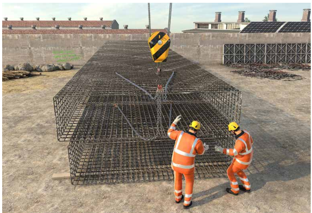
Abb. 132 Anschlagen eines Bewehrungskorbes
