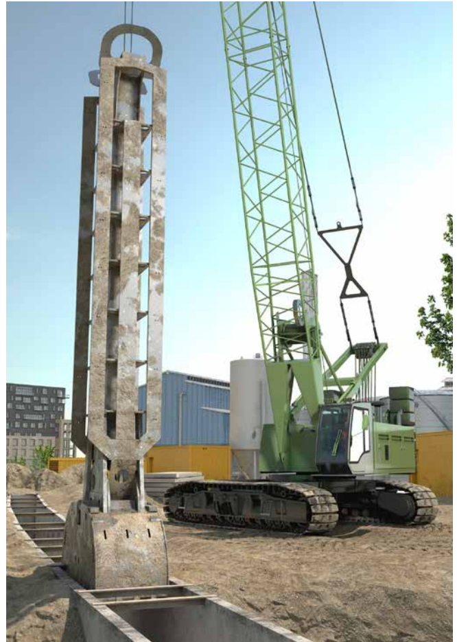
Abb. 133 Schlitzwandarbeiten
