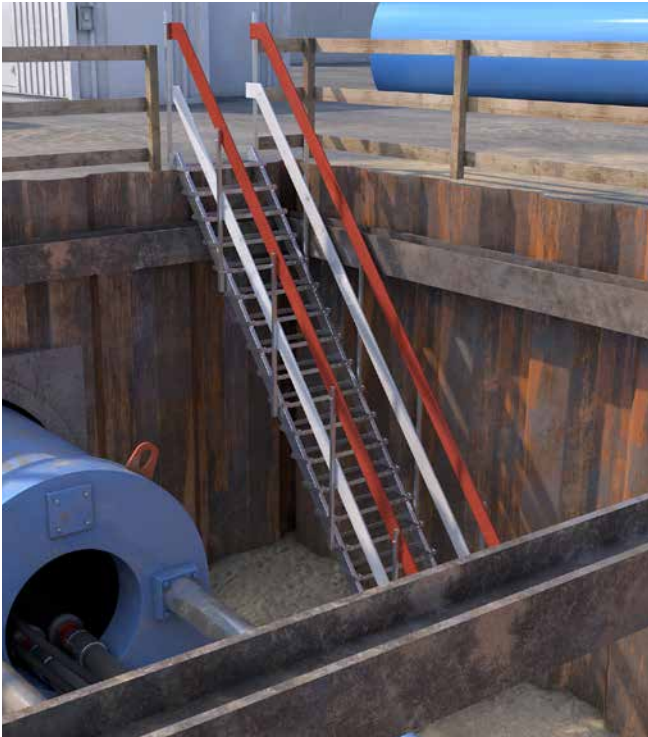
Abb. 5 Treppe als Zugang zur Baugrube
