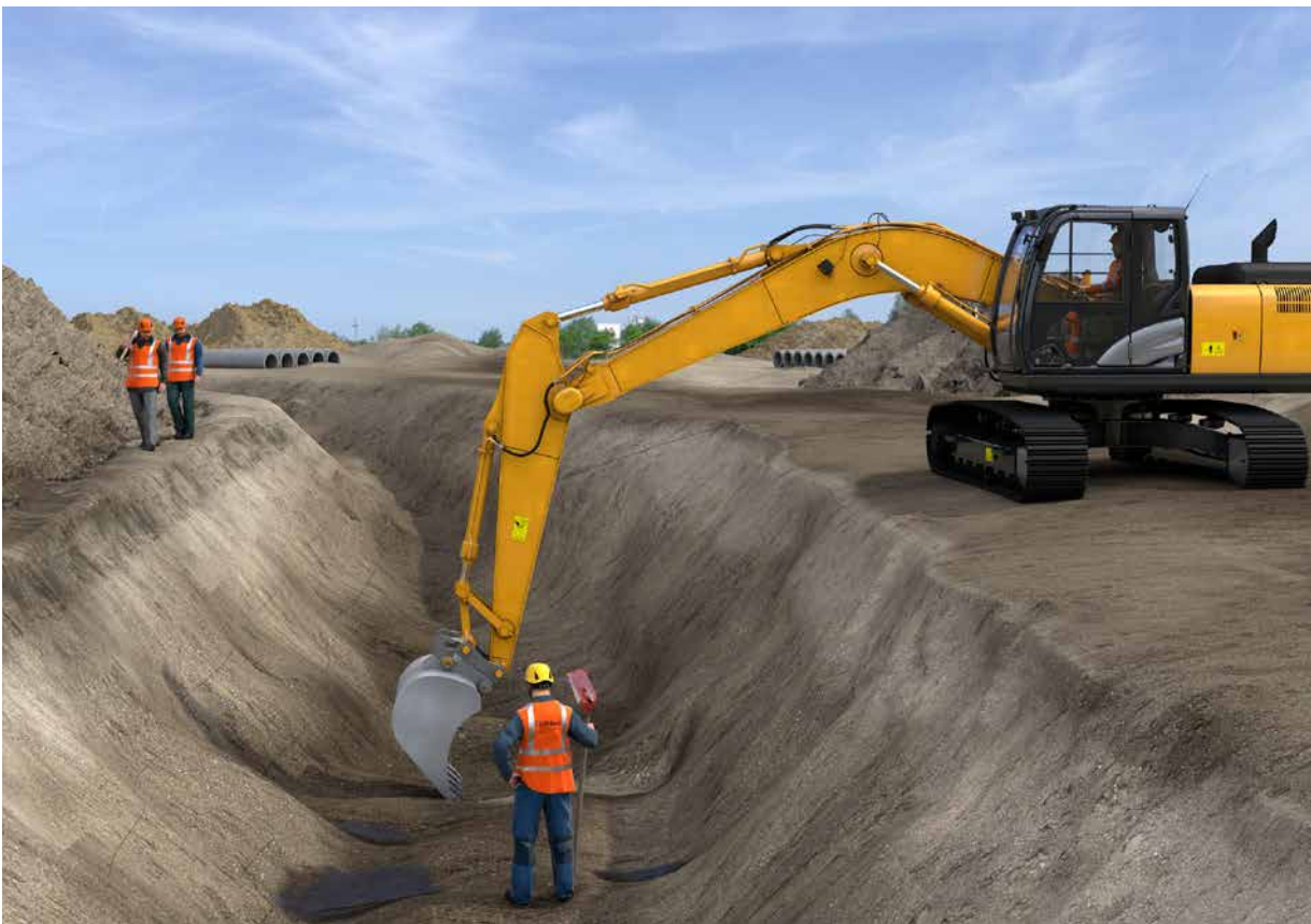
Abb. 104 Schutzstreifen an Baugruben/Grabenrand
