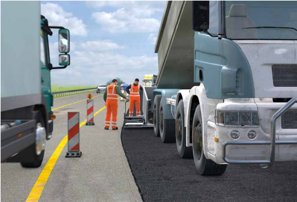
Abb. 8 Absicherung durch Leitbaken
