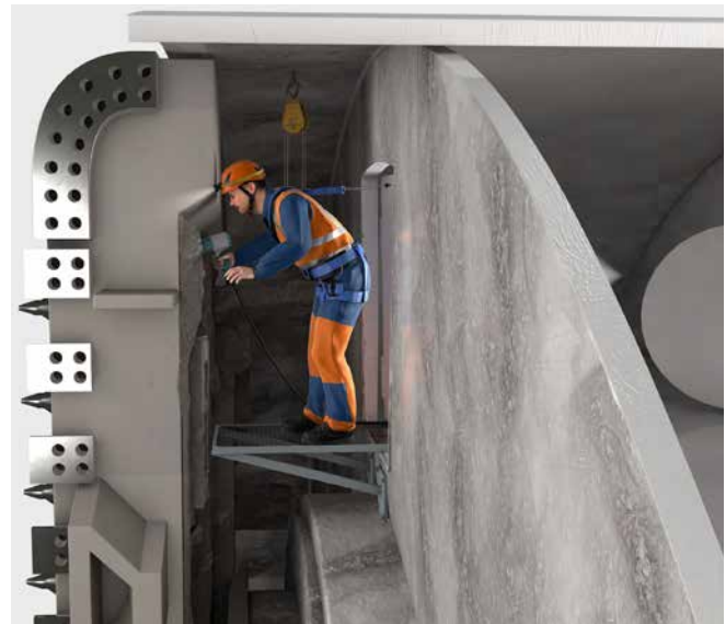
Abb. 141 Arbeitsbühne und PSA beim Werkzeugwechsel
