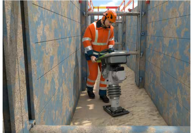
Abb. 93 Verdichtungsarbeiten mit einem Akku betriebenen Stampfer
