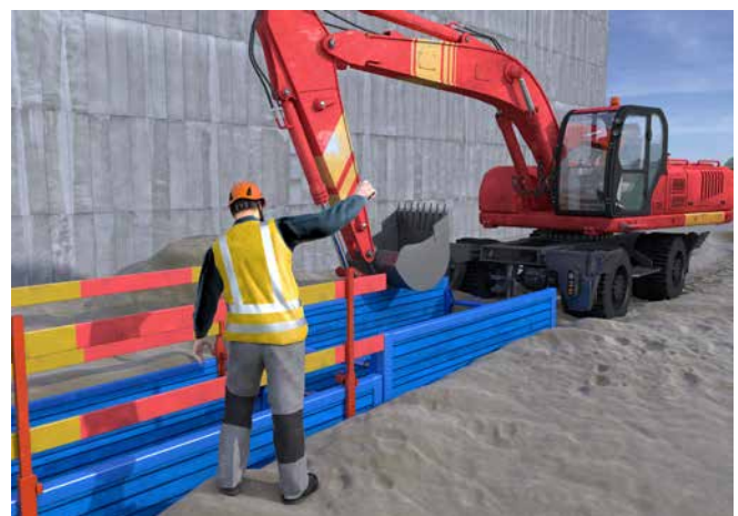
Abb. 112 Absturzsicherung am Verbau
