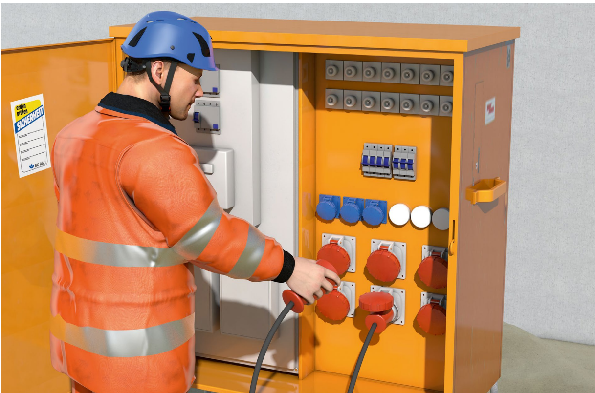
Abb. 27 Verschließbarer Baustromverteiler mit 30 mA und 500 mA Fehlerstrom-Schutzeinrichtungen (RCDs)
