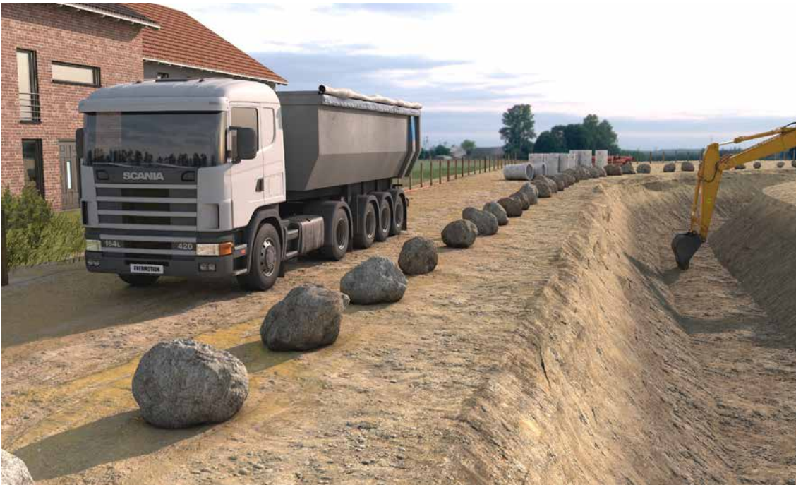
Abb. 76 Begrenzung des Fahrweges durch Freisteine
