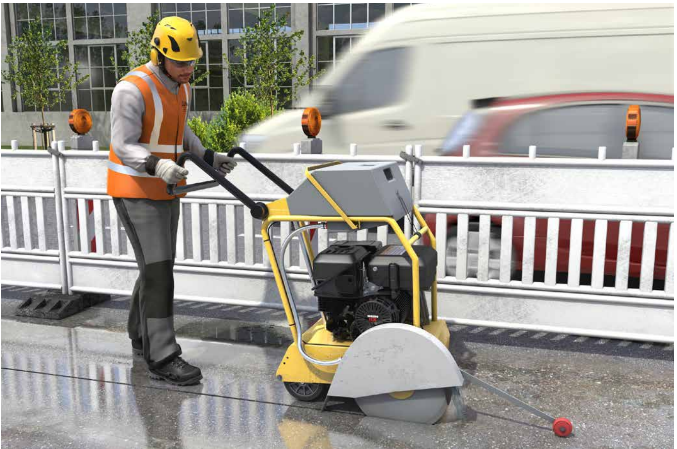
Abb. 12 Staubminimierung durch Nassschneiden
