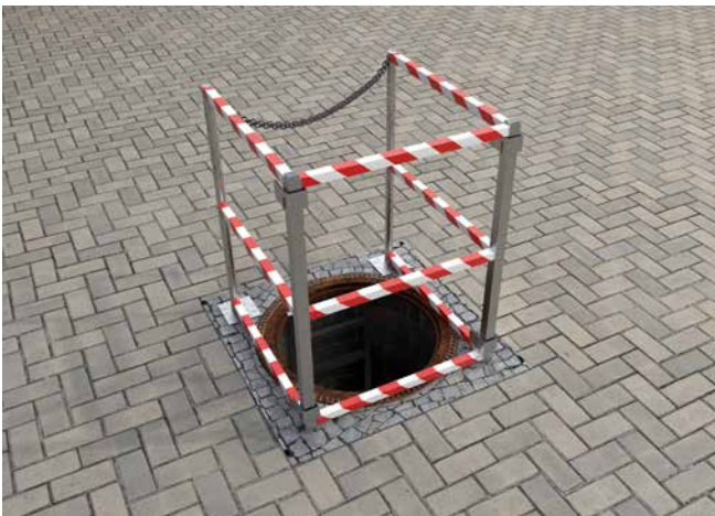
Abb. 116 Absturzsicherung an einem geöffneten Schacht
